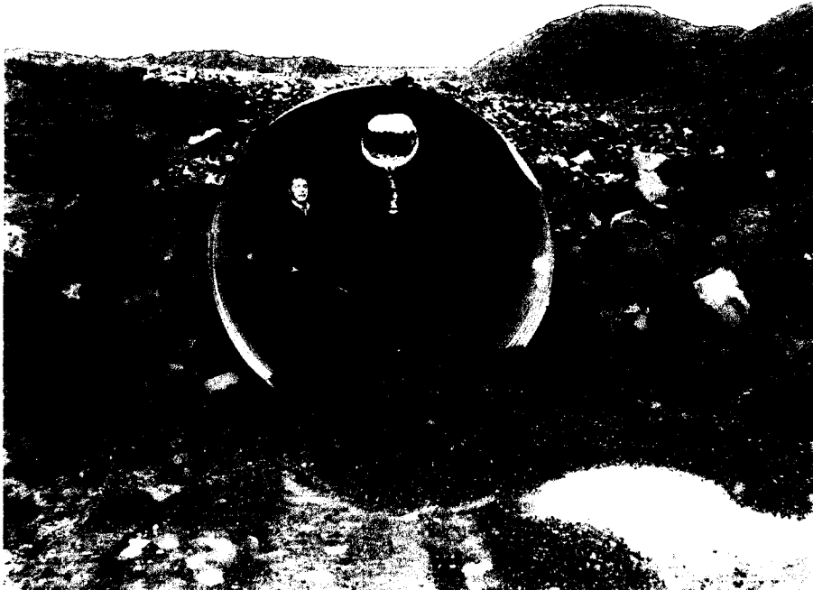
Undirgöng undir Suðurlandsveg í landi Þjórsártúns, búfjárgöng þar sem hægt á að vera að reka hross um göngin. Þvermál rörs er 2,8 m, lengd 42 m.
