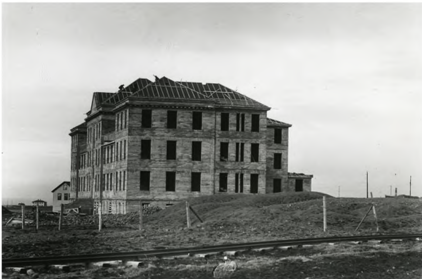
Aðalbygging Landspítalans við Hringbraut í byggingu. Ártal óþekkt. Mynd: Landspítali – Háskólasjúkrahús.
